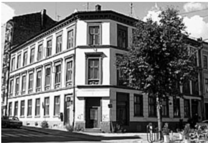
Fasade av bygning fra 1870-tallet
