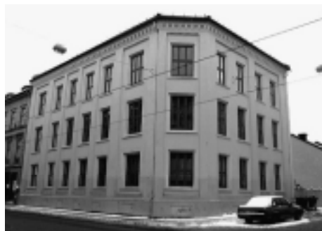
Oslogate 16 etter istandsetting med hydraulisk kalkpuss.
