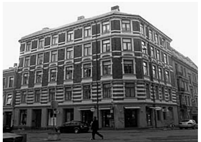
Fasade av bygning fra 1890-tallet
