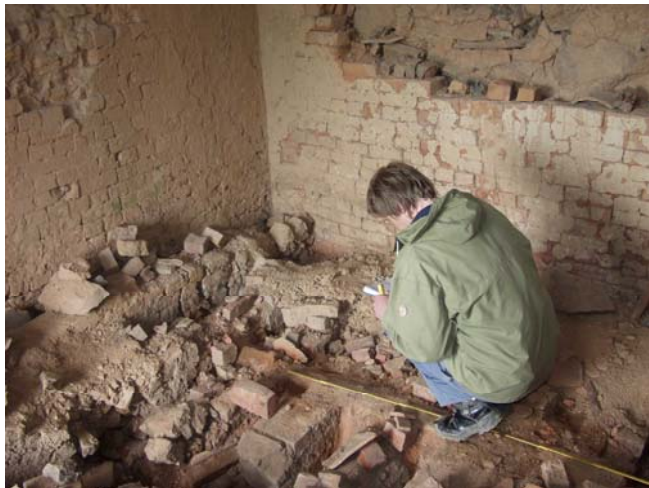
Fra oppmålingsarbeidet i 2004. Den innvendige foringen ses på veggene. I bunnen sammenraste fyringskanaler.
