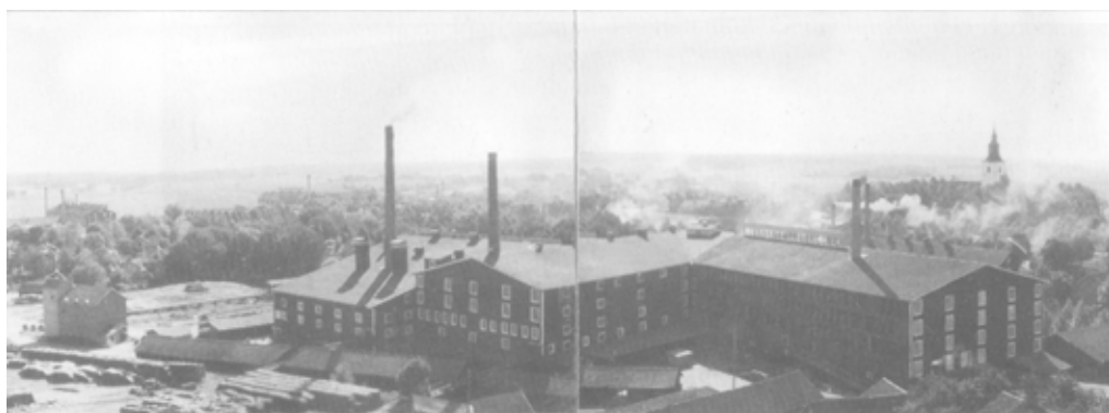
Två fotografier ur Sven Sköldbbergs gamla fotoalbum som hopfogats till ett. I högra byggnaden låg ringugnerna för murtegel. I de centrala och vänstra delarna brändes takpannor i flamugnar.
