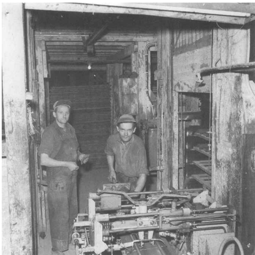
Trångt och bullrigt, dåligt ljus och med en arbetsställning som slet. Så var det på alla tegelbruk. Vid den här pressen lade man råteget direkt in i hissen.
