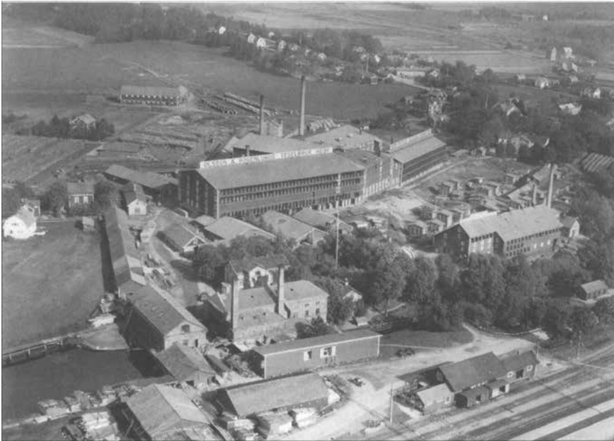
Till vänster i förgrunden Olsson & Rosenlunds snickerifabrik. Där ovanför tegelbruket med långa skyltar på taket. Framför till höger ligger Lantmännens tegelbruk. Foto från 1938.
