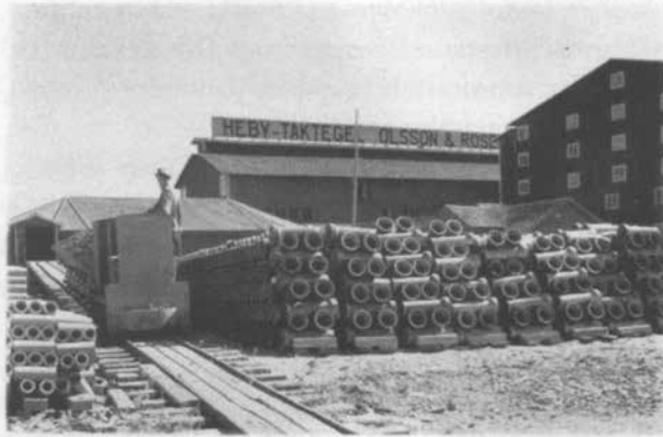
Tägsättet med lervagnar på väg till nya lersumpen, som uppförts år 1940 efter ritningar av Professor H. Kreuger.
