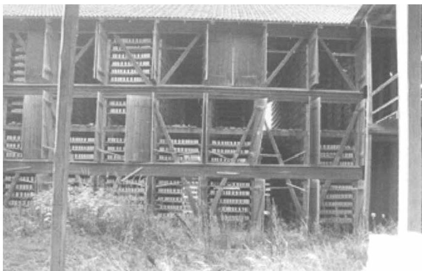
Typisk fristående torkbyggnad ("lada") med öppningsbara väggar. Används fortfarande för torkning av murtegel i Bälstarbo utanför Hedemora.
