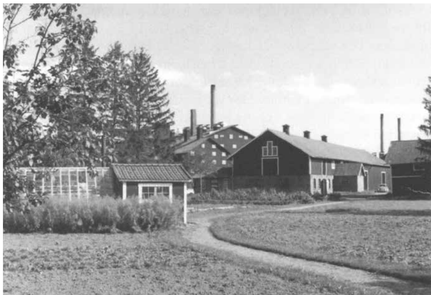
Strömsvik med växthus, egen trädgårdsmästare, stall och vagnbod låg alldeles inpå det bullrande tegelbruket.
