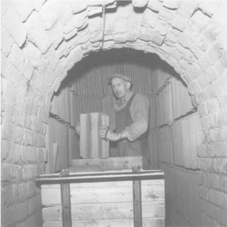
Flamugn som sätts med taktegel.
