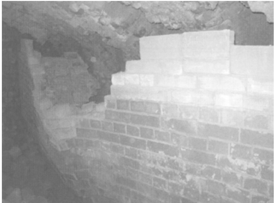
Rester av en eldstadsbrygga i Västerbo tegelbruk.
